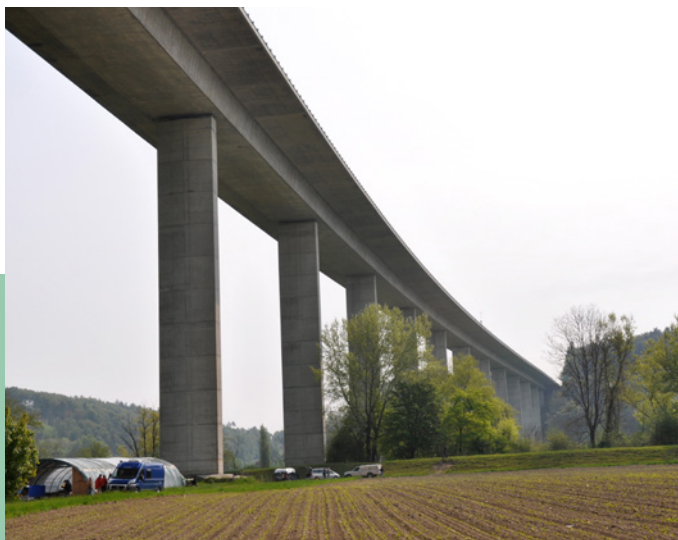
Paysage d'infrastructure: viaduc autoroutier de l'A1 près de Wileroltigen BE (photo: Barbara Marty).
