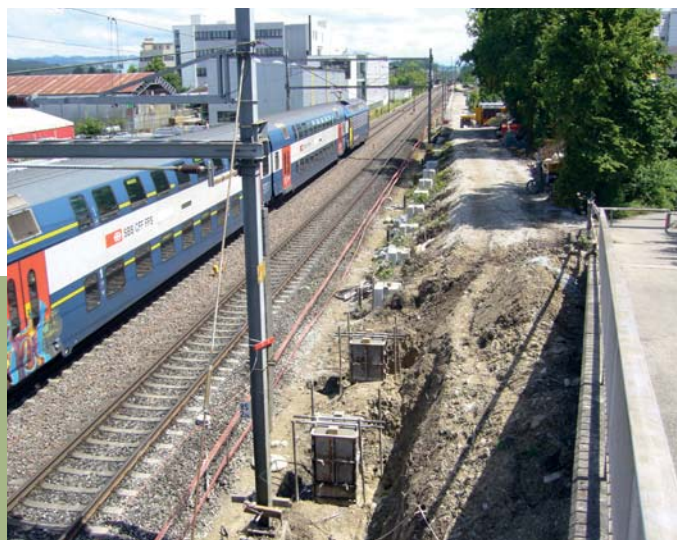
Abb.5: LSW-Bau an einer Bahnstrecke (Foto: C. Mayer).
