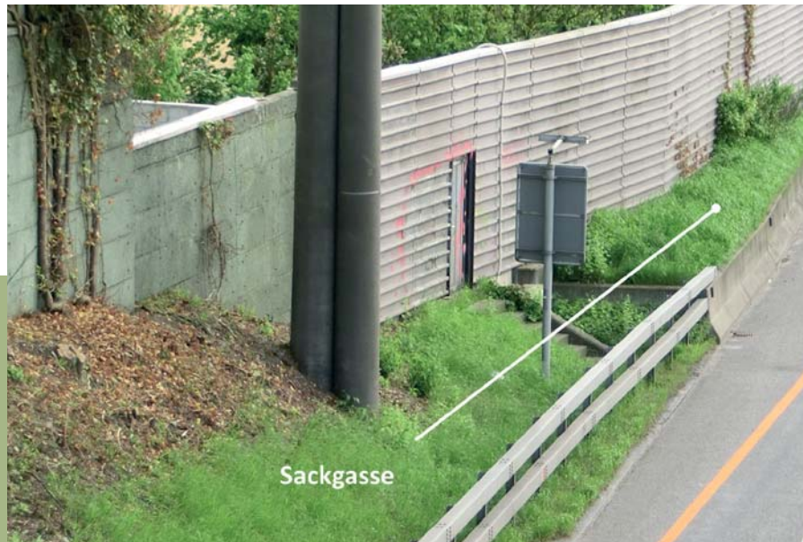
Abb.3: Diese Böschung führt wegen der zunehmend strassennahen Platzierung der LSW in eine Sackgasse (Foto: C. Mayer).
