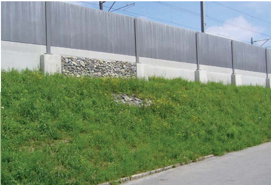
Fig. 2: Un gabion intégré à une PAB. Devant le gabion, un amas de pierres préservé sur le remblai, afin de servir d'abri aux reptiles (photo: C. Mayer).
