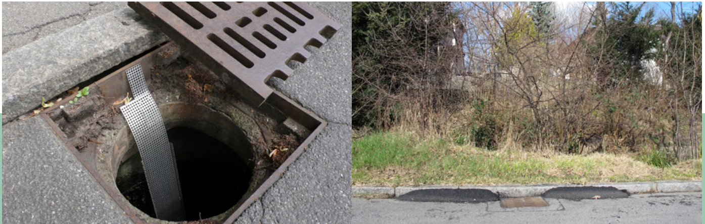
Fig. 2: Des échelles pour amphibiens permettent aux animaux de s'extirper eux-mêmes de la bouche d'égout (à gauche), tandis que les rampes goudronnées empêchent les animaux de tomber dans la bouche (à droite) (photo à gauche: Simon Gaus; photo à droite: Stefan Hose).
