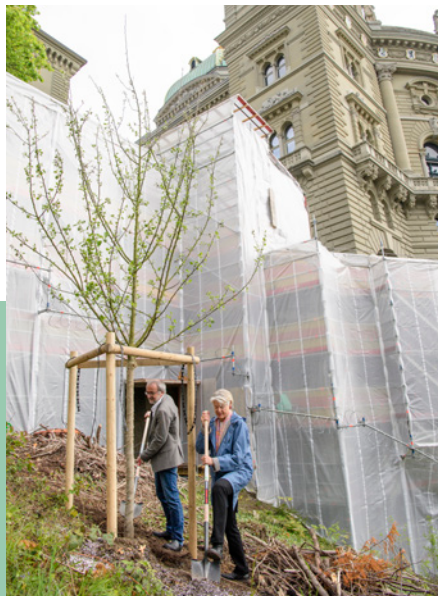
Fig. 2: 25 ans après la fondation du FSP : plantation d'un pommier sauvage au pied des vieux murs de soutènement (actuellement derrière un échafaudage) du Palais fédéral (photo: Béatrice Devènes / FSP).
