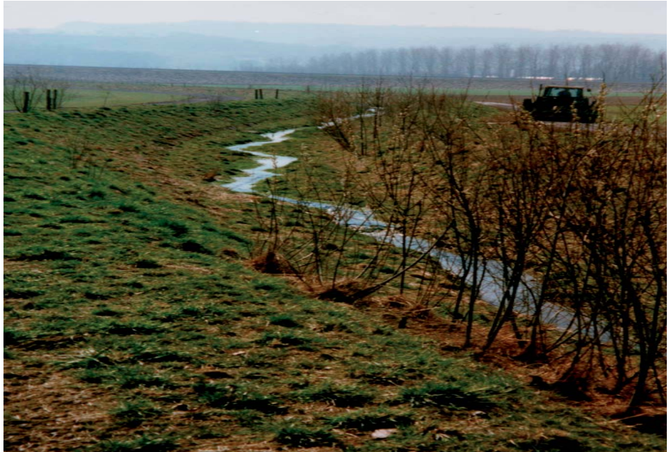
Abb.1: Durch die Ausdolung eines Gewässers im Rahmen einer Bodenverbesserung kann der Bundesbeitrag um 2-3 % erhöht werden.
