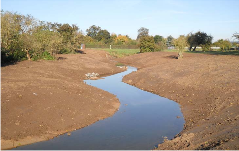
Abb. 2: Der neue Verlauf des Braubachs direkt nach der Renaturierung im Herbst 2011. Der neue Gewässerlauf ist geschwungen und die Uferböschung verläuft flach (Foto: J. Gramatzki; Ökobüro Gelnhausen).
