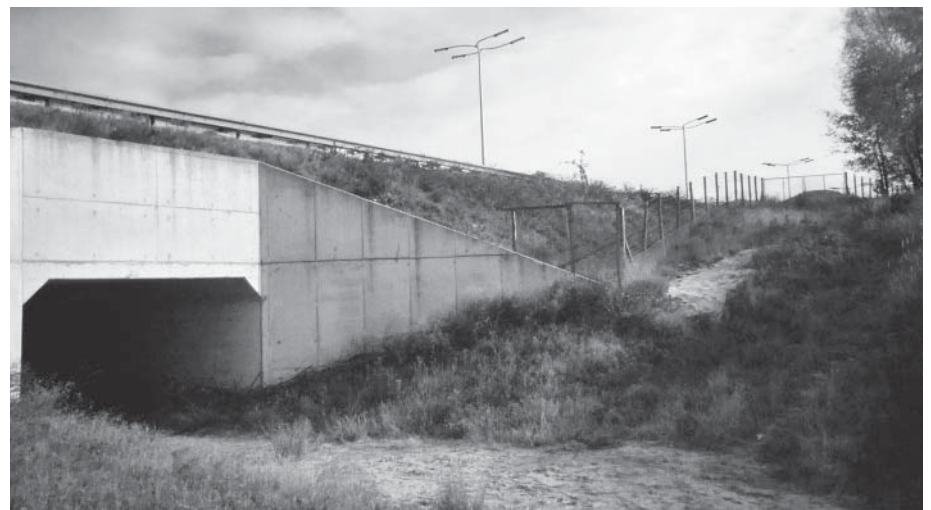
Abb. 3: Unterführung für Wildtiere an einer Autobahn (Beispiel aus den Niederlanden). Zäune leiten die Tiere zur Unterführung hin. Bild: J. Jaeger.
