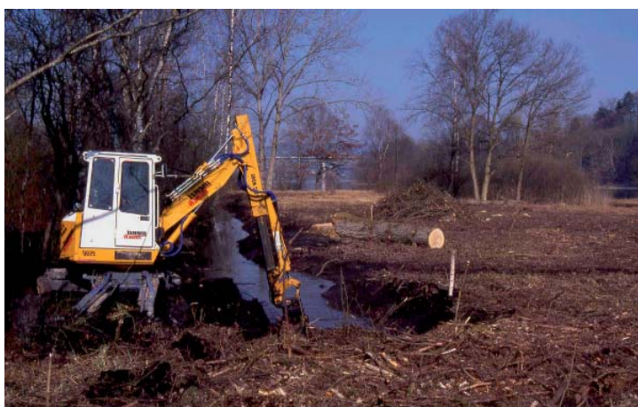
Abb. 5 Holzarbeiten und Weierbau im Naturschutzgebiet «z'Hose», Stein am Rhein: Das ehemalige Streueland «z'Hose» lag mehrere Jahrzehnte brach. Seit Anfang der Neunzigerjahre wird das Feuchtgebiet wieder regelmässig gepflegt und aufgewertet. Foto: Martin Bolliger
