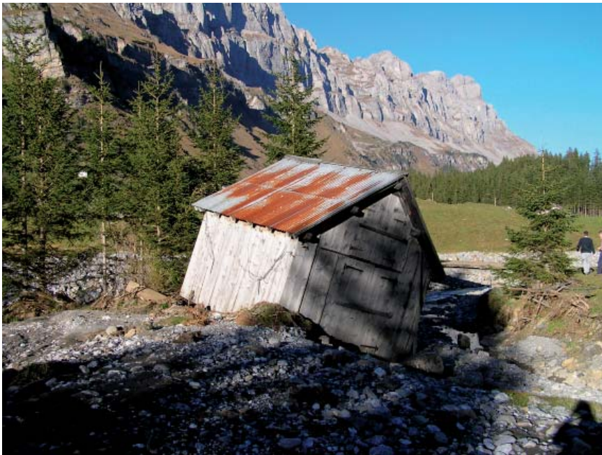
Abb.1: Weggeschwemmtes landwirtschaftliches Gebäude auf dem Urnerboden.
