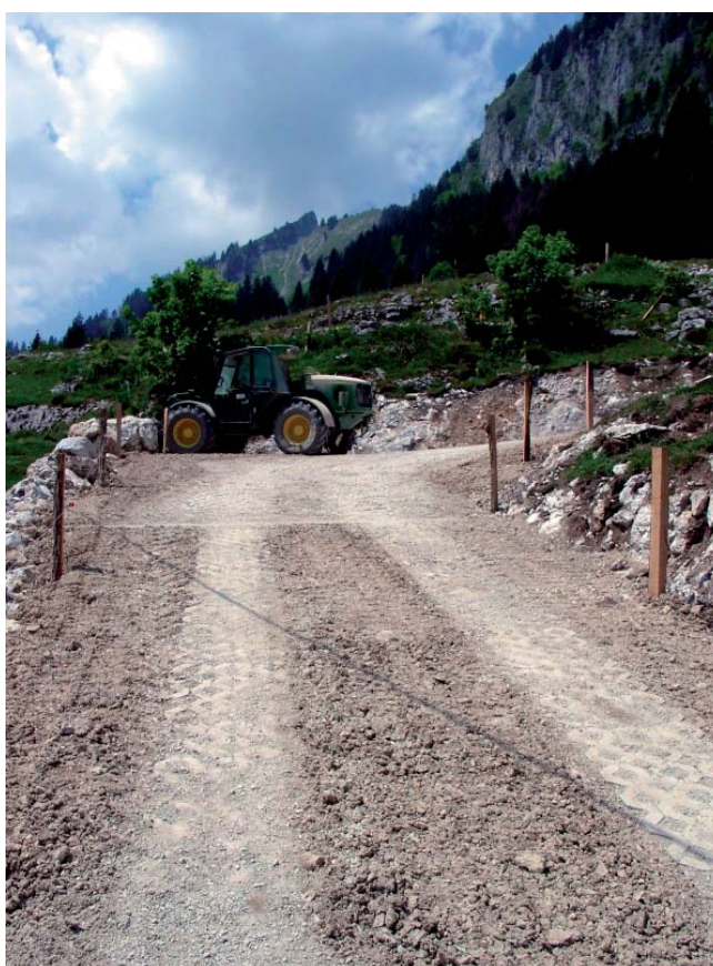
Abb.1: Bau eines Spurwegs aus Gittersteinen, BLN Breccaschlund FR (Foto B. Magnin). Seiten- und Mittelstreifen werden anschließend begrünt.
