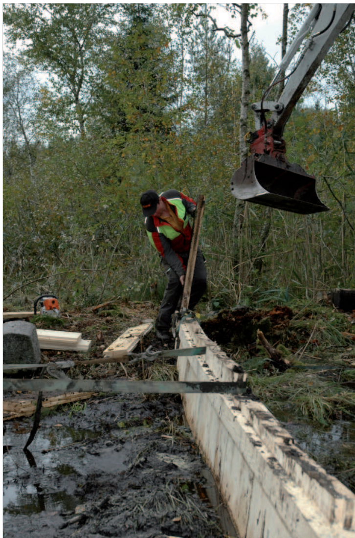
Fig. 3: Mise en place d'une digue en bois dans la première semaine de septembre 2010 (photo: St. Steger).
