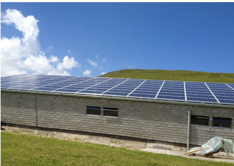
In die Dachfläche integrierte Photovoltaikanlage auf der Alp Staviola Vedra, Lumbrein (GR) (Foto: Stiftung Landschaftsschutz Schweiz).
