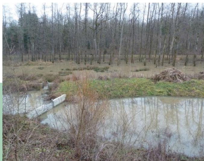
Batardeaux mis en place aux Prés Bordon (photo: DGAN).
