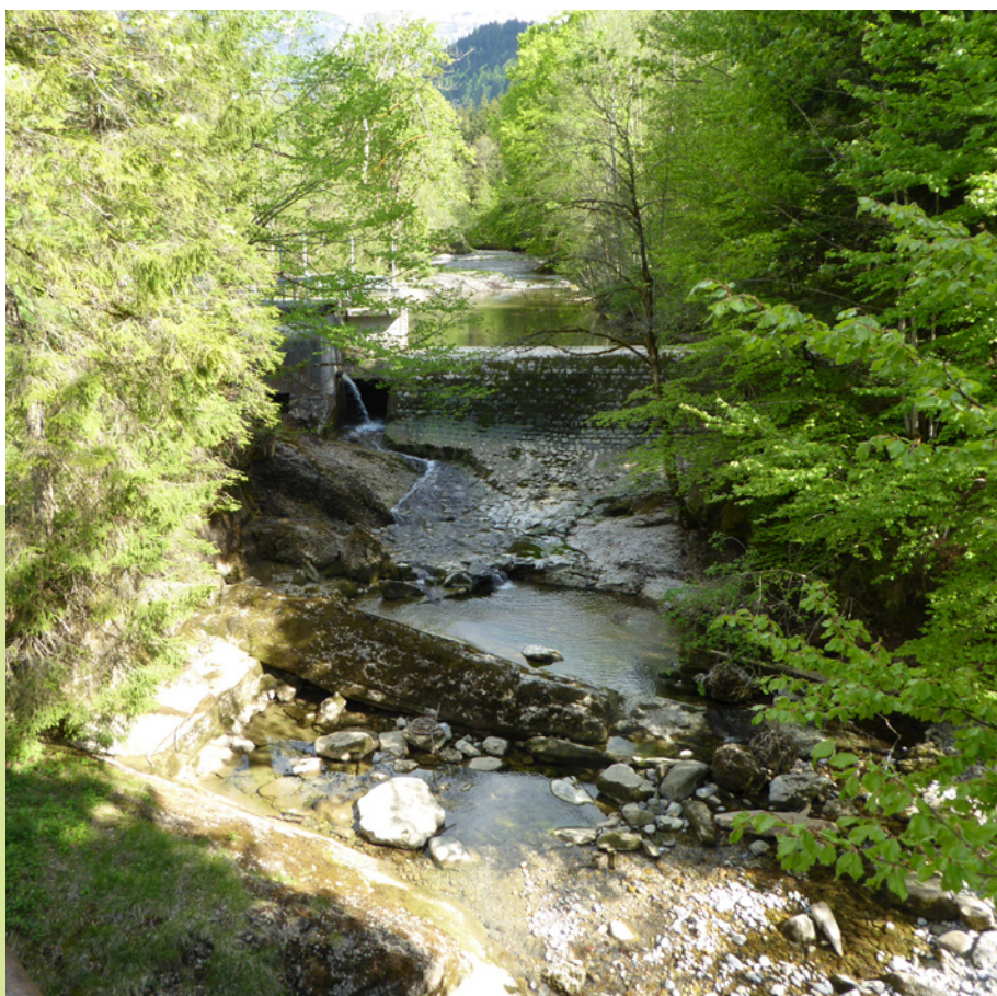
Wasserfassung eines Kleinwasserkraftwerks (Symbolbild) (Foto: M. Gassner).
