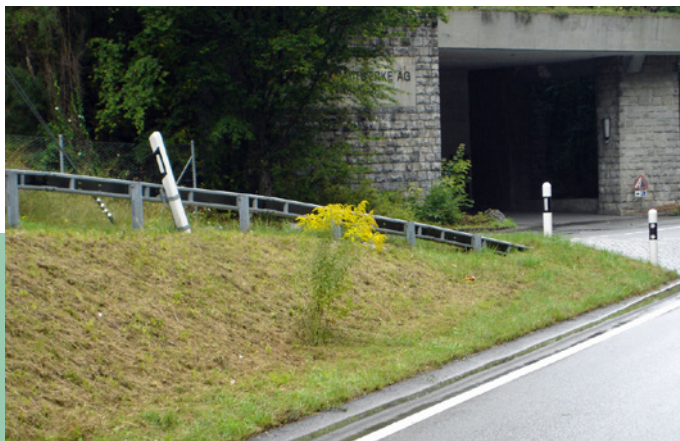
Fig. 3: Mauvais exemple: talus mulché où la seule plante laissée intacte est la néophyte envahissante (photo: Ruedi Wyss, SPN).
