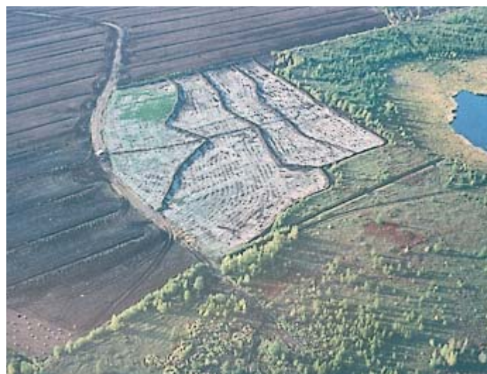
Figure 9. Photo aérienne du site en restauration d'Inkerman Ferry, au Nouveau-Brunswick. Les digues ont été disposées le long des courbes de niveau obtenues par un relevé topographique. Les travaux de restauration ont eu lieu à l'automne 1997 et la photo a été prise en septembre 1998. (Photo : F. Quinty)
