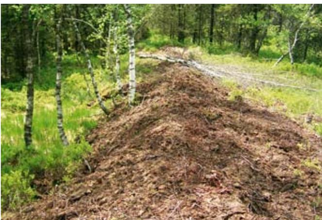
Abb. 106 Mit Torf abgedeckte Holzspundwand, Le Cerneux-Péquignot (NE), Marais des Saignes-Jeanne
