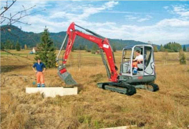
**Abb. 88** Einsetzen von Platten, am oberen Ende des Grabens beginnend
