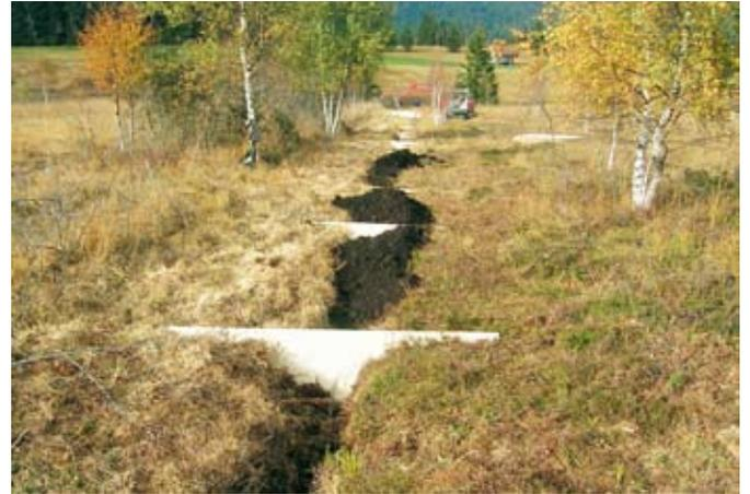
**Abb. 89** Mit Platten in regelmässigen Abständen eingestauter und mit Torf verfüllter Graben
