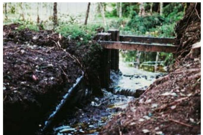
Abb. 108 Wasserregulierung durch einen Holzkasten; die quer zur Abflussrichtung liegenden Bretter bestimmen die Stauhöhe hinter dem Bauwerk; mit zusätzlichen Brettern kann die Staukote der Vegetationsentwicklung angepasst werden.
