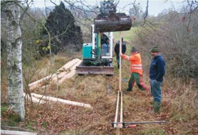
Abb. 101 Einrammen der Bretter mithilfe eines Kleinbaggers
