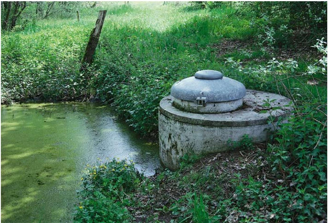
Abb. 117 Wasserregulierung durch einen Regulierschacht mit Regler; entsprechend der Vegetationsentwicklung kann der Wasserstand nach und nach angehoben werden; das Wasser wird in einen tiefer liegenden Bach abgeleitet.
