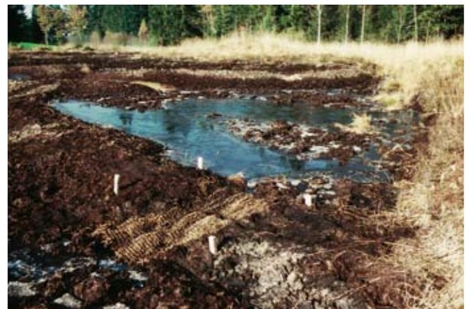
Abb. 56 Mit Kokosmatten ausgelegter Überlauf an einem Torfwall, Eggwil (BE), Kantonales Naturschutzgebiet Steinmösli
