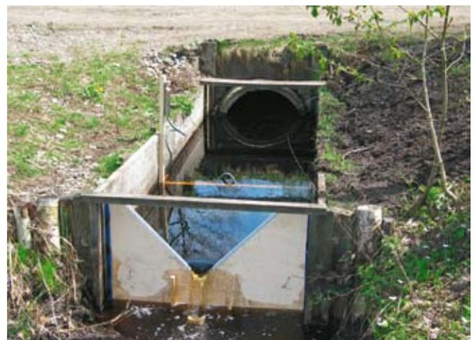
**Abb. 12 Normiertes Überlaufwehr**
