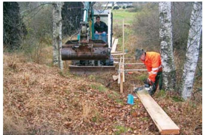
Abb. 103 Abschrägen der Brettspitze mithilfe der Motorsäge
