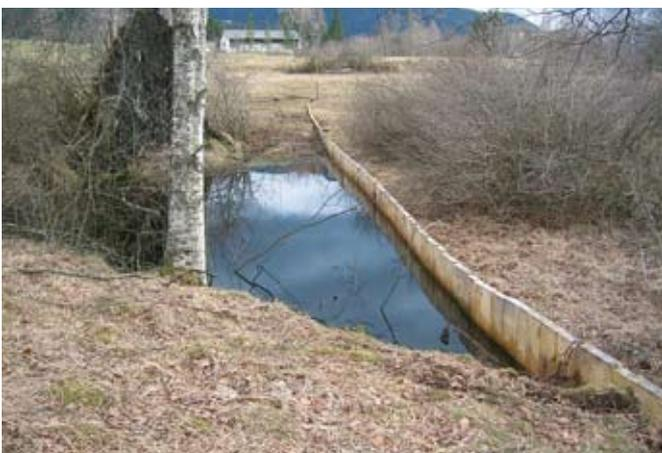
Abb. 104 Fertig eingesetzte Spundwand vor dem Abdecken mit Torf, Walchwil (ZG); Hochmoor Früebüelmoos
