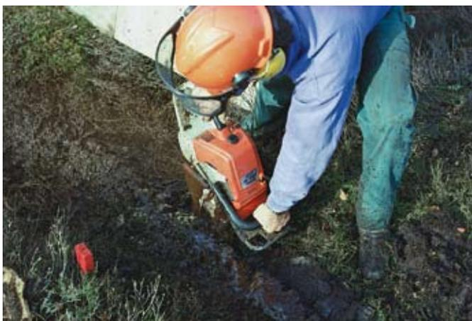
Abb. 74 Aussägen des Torfkörpers und Zersägen von im Boden vorhandenem Holz mittels Motorsäge mit langem Schwert
