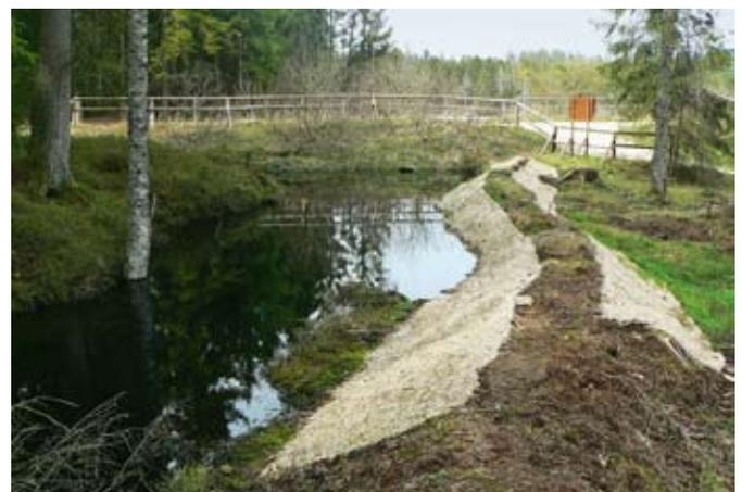
Abb. 107 Strohmatte zum Schutz des Dammes gegen Erosion, Saignelégier (JU), Etang de la Gruère
