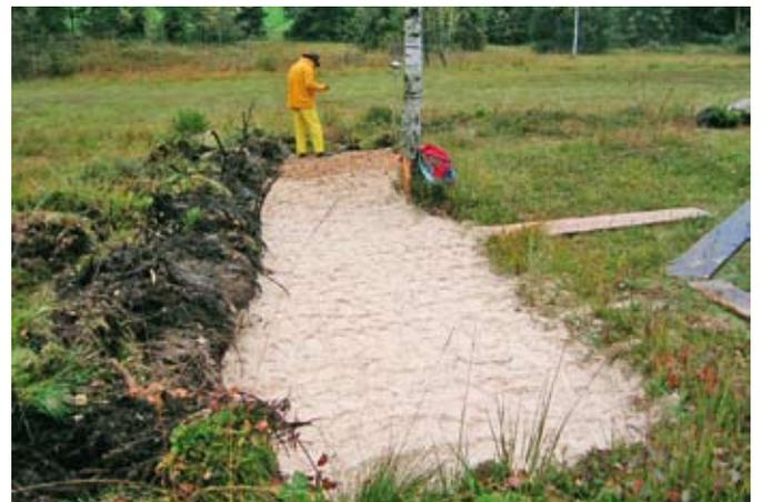
**Abb. 93** Variante: Verfüllen des Grabens mit Sägemehl (Zuger Methode)
