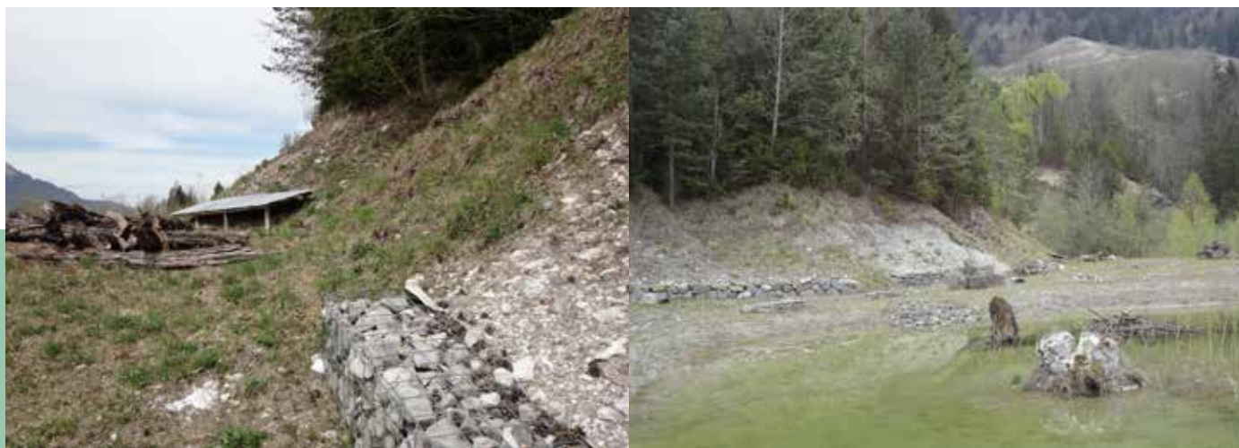
Fig. 2: Une mise en valeur de l'habitat terrestre a été réalisée en 2016 autour des nouveaux étangs. Des structures en pierre et des talus au substrat meuble fournissent des caches favorables (photos: M. Jakober).
