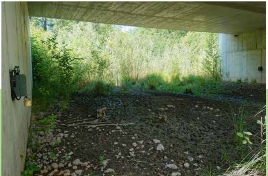
Fig. 1: Passage à faune inférieur au Fanel (© WLS.CH).
