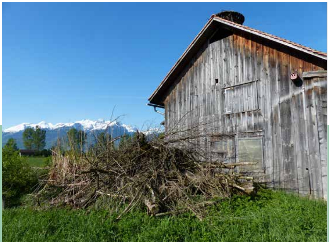
Fig. 3: La plateforme fixée sur le toit et le nichoir ouvert accroché à la façade sont bien visibles. On ne distingue le nichoir fermé que grâce à ses trous d'accès, aménagés en haut à gauche et en bas à droite (photo: Pro Riet).
